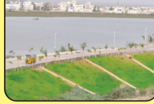
MINI TANK BUND
